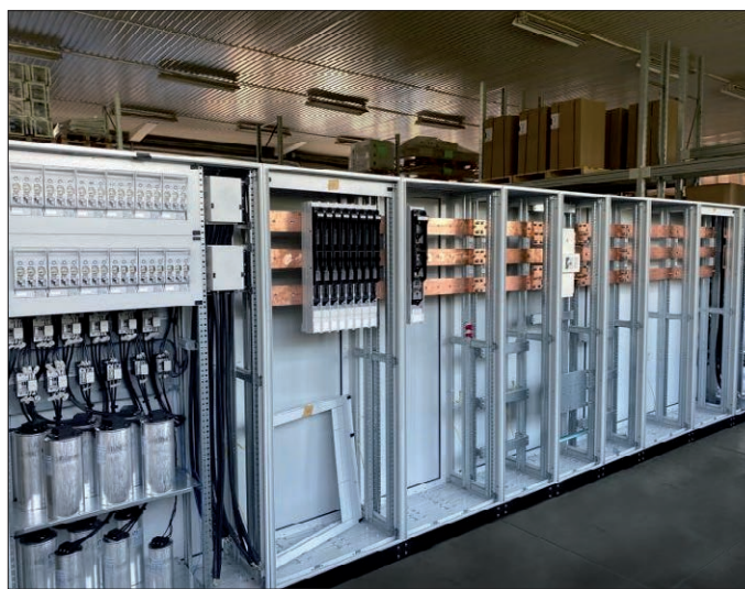
Rys. 1. Proces prefabrykacji rozdzielnic niskiego napięcia wyposażonej w baterię kondensatorów oraz listwowe rozłączniki bezpiecznikowe
